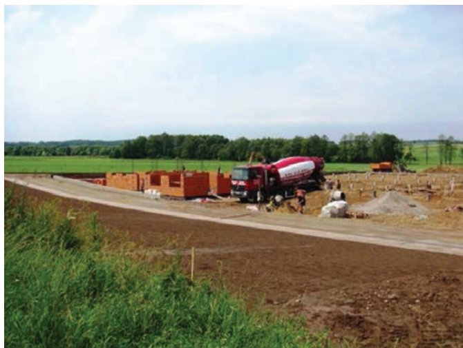
Ul. Kolneńska – Targowica w budowie
