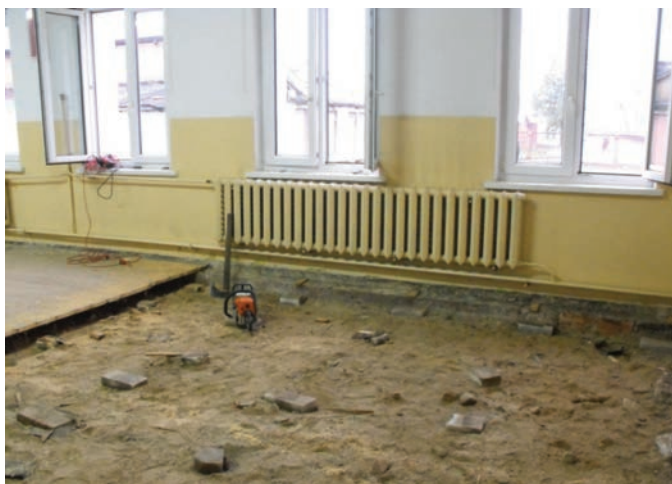
Prace remontowe w OSP – wymiana podłogi
