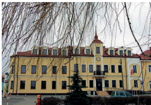
Gmach UM w Szczuczynie po przebudowie
