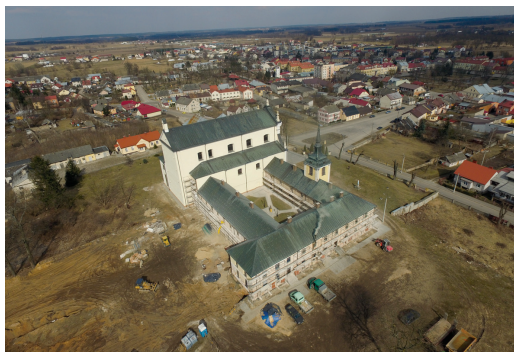
Remont klasztoru pijarskiego
