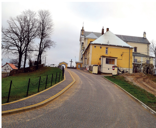
Nowy podjazd do kompleksu klasztorowego w Szczuczynie
