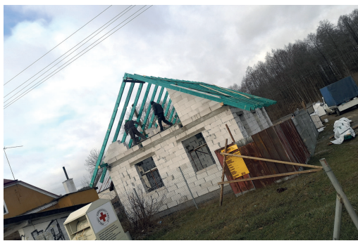
Budowa świetlicy w m. Guty
