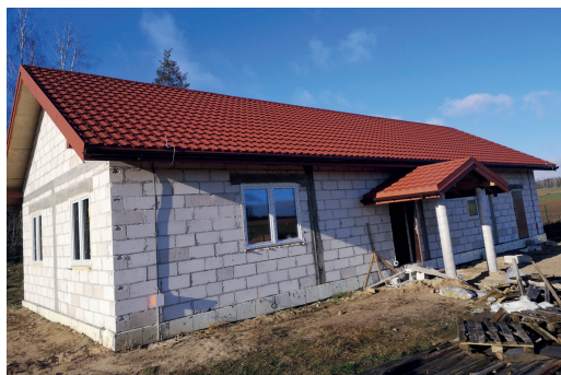
Budowa świetlicy w Kurkach
