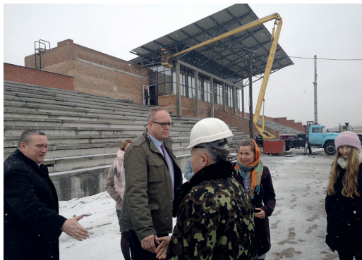
Burmistrz Szczuczyna z wizytą na budowie stadionu w Kowlu na Ukrainie
